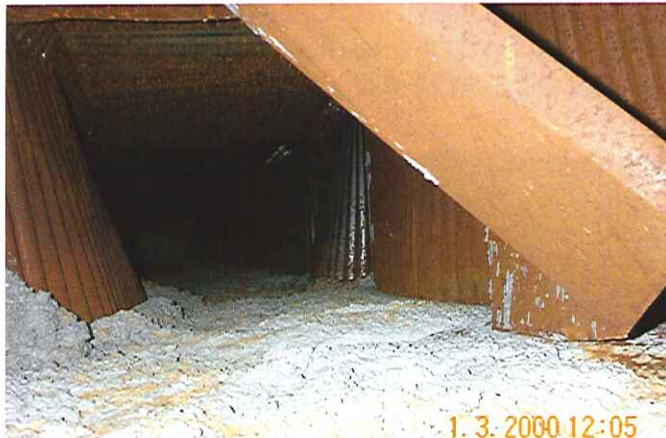
תעלה בתקרת פלקל עם פגמי ייצור
