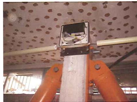
מגבהים של חברת בטון דרוך ומעליהם מערכת הניטור של חברת גבי שואף
