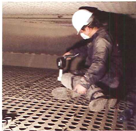
תרשים 3: בדיקת Tubular Air Heater בעיצומה
